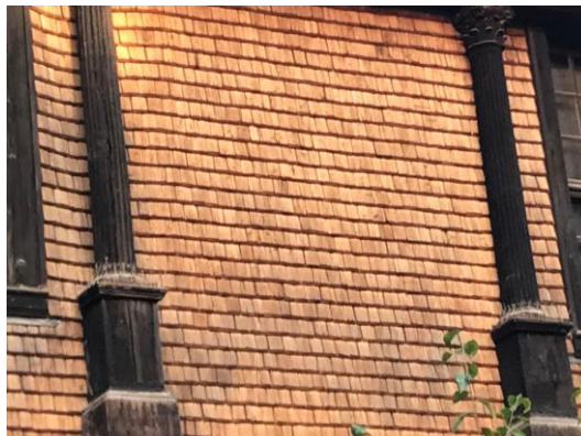
Façade recouverte de tavaillons
