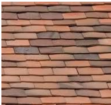
Toiture en tuiles plates
