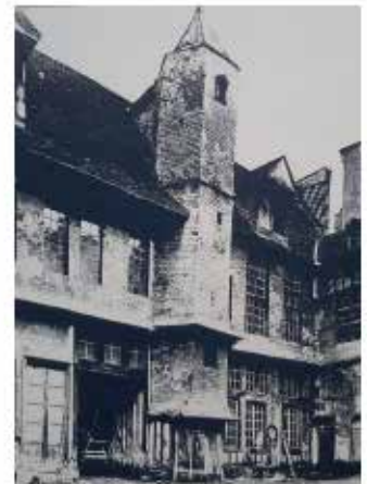
Photographie montrant les dégâts sur la tourelle incendiée en 1902.
